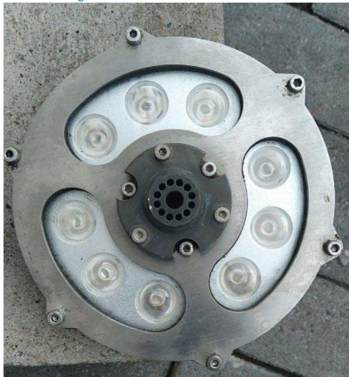
Fotografía 2 Luminaria de la pileta rítmica retirada
